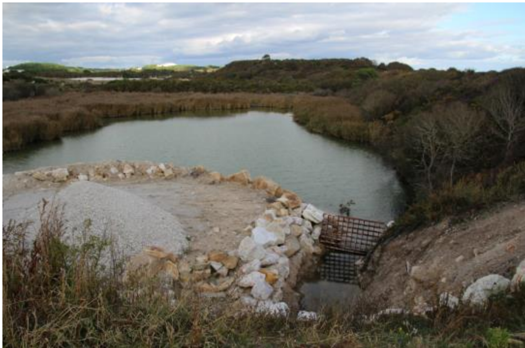
Figure 43 : Exutoire du bassin Sud Lanvrian avant passage sous RD 152 (ENCEM)
